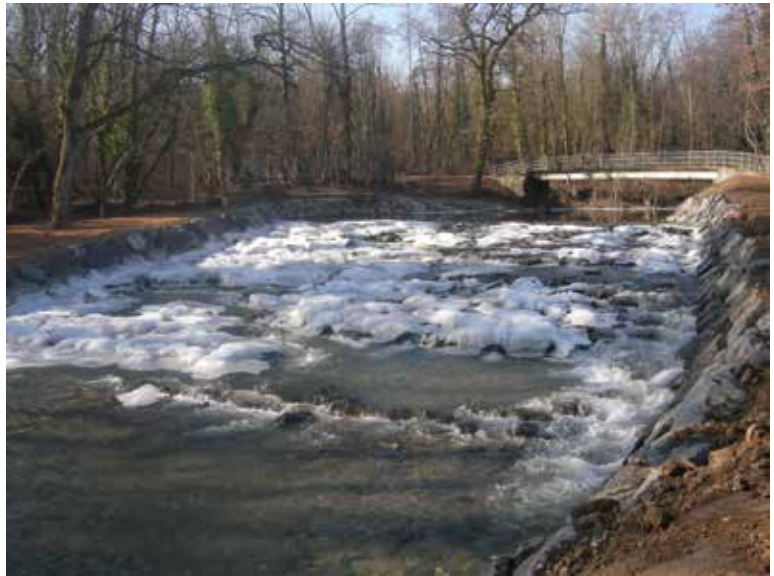
Photo 2 – Rampe en enrochements sur la Venoge, affluent du Léman (© F. Hofmann)
