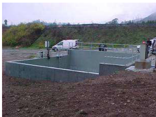
Photo 7 : Bassin de rétention BE1
