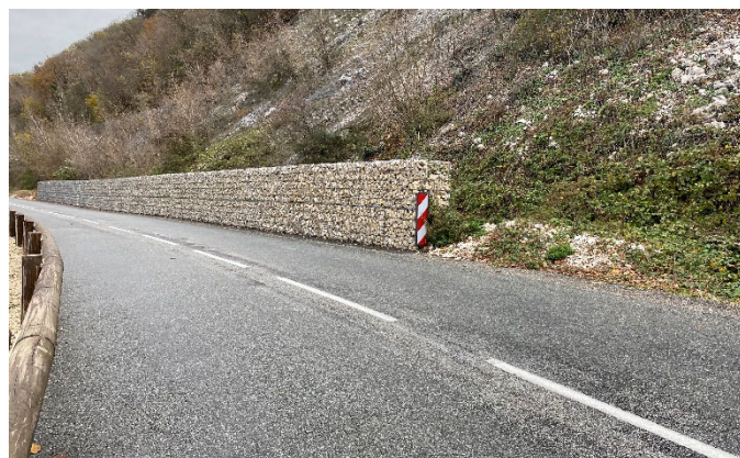
Photo 12 : Merlon en gabion
