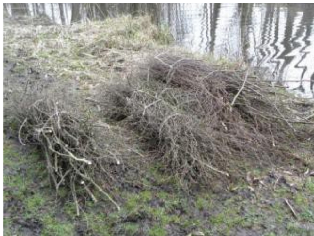
Photo 27 : Fagots réalisés avec des branchages de feuillus
