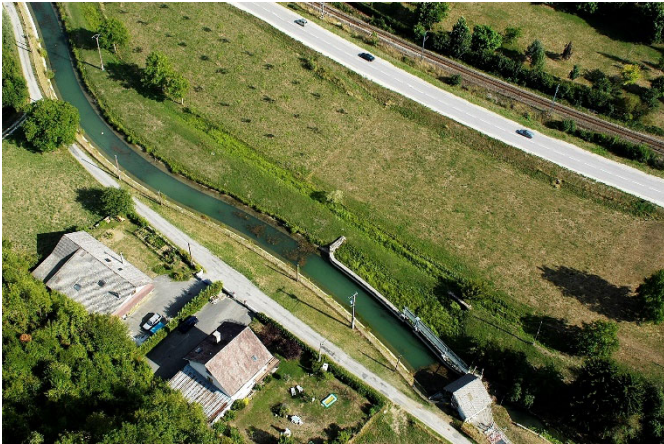
Photo 8 : Canal du Thiers
