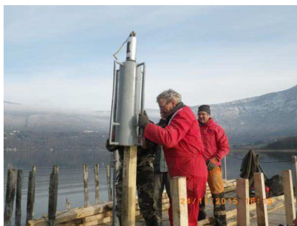
Photo 26 : Frayère en cours de rénovation
