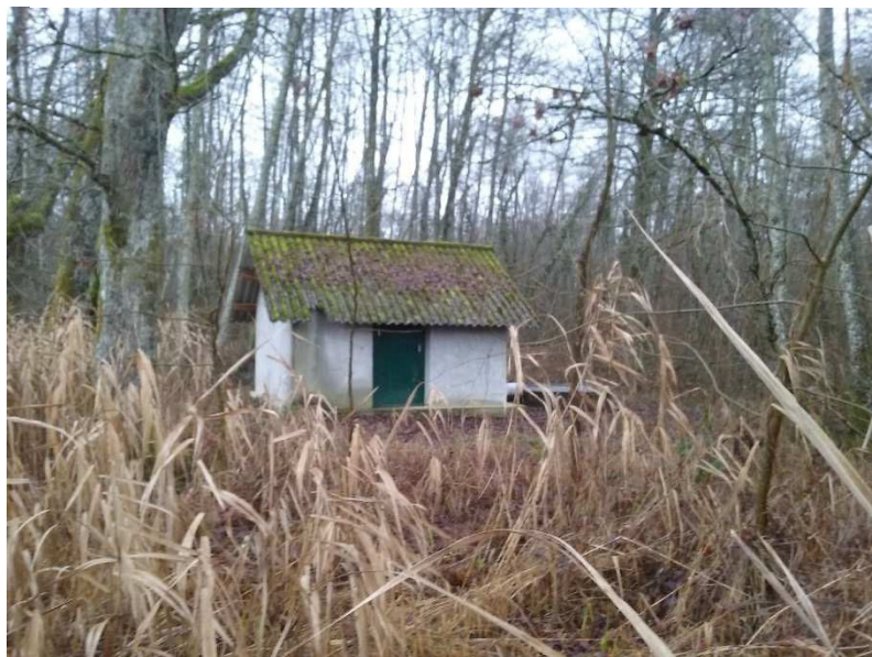
Photo 22 : Station de pompage de lépin
