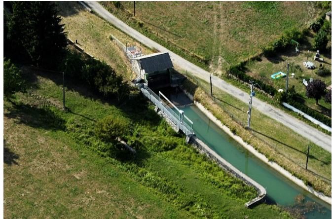
Photo 7 : barrage de prise d'eau
