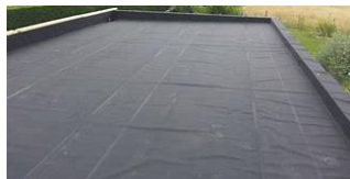
Membrane d'étanchéité EPDM et PIB
